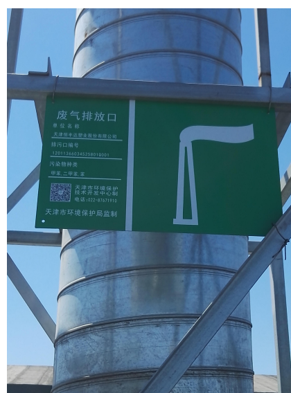
图 2 废气排气筒规范化标识
