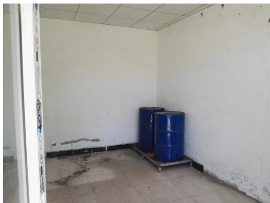
图 3 危险废物暂存间
